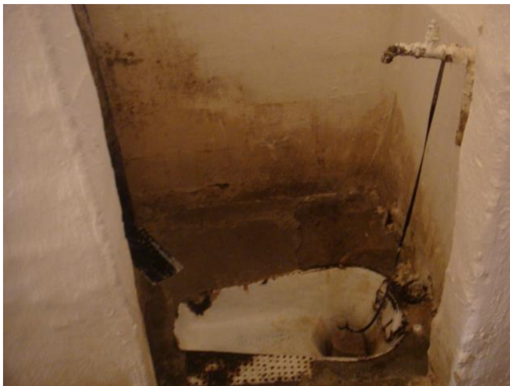
Foto nr. 4 – Blocul sanitar al celulei nr. 46
